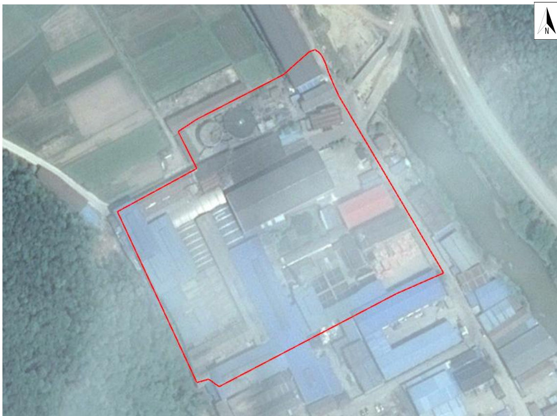
2013年影像图（光明造纸厂停产，出租给杭化机封头、灵桥第二预制板厂等）
